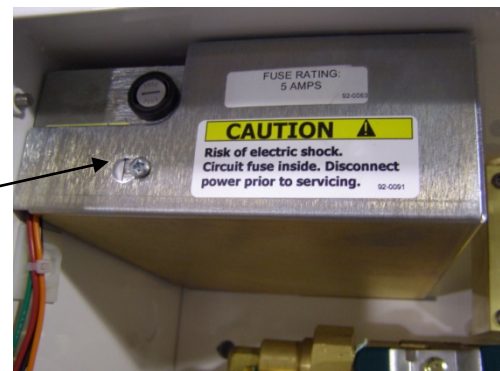
Conduit knockouts for 120 VAC
